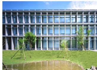
写真-1 南面外観
