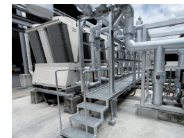
据付完了後の様子
