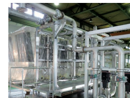
工場でのユニット製作の様子
