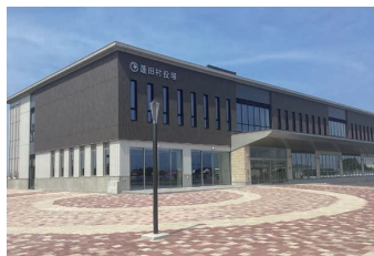
施設名 : 蓬田村役場(庁舎棟・車庫棟) 所在地 : 青森県東津軽郡蓬田村 竣工年 : 2025年 工事区分 : 空調衛生設備工事
