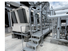
据付完了後の様子
