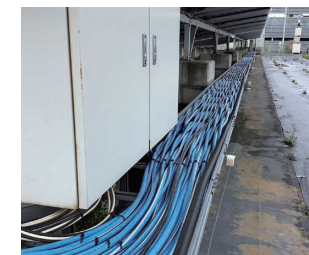
アルミ線へのリニューアル工事
