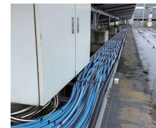
アルミ線へのリニューアル工事
