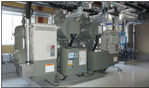
水冷式2段圧縮スクルー冷凍機
