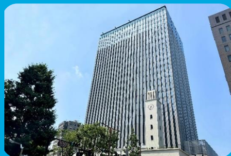
川崎市役所本庁舎
