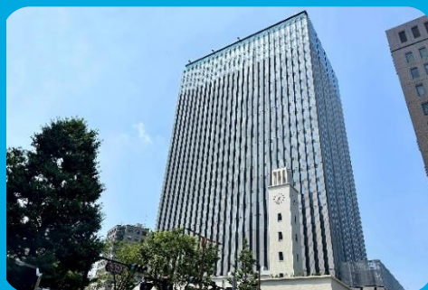
川崎市役所本庁舎
